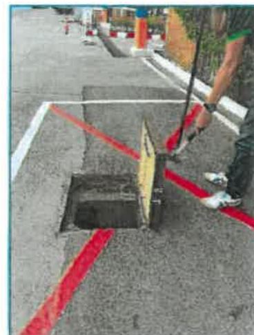
บ่อพักน้ำทิ้งสุดท้ายก่อนระบายออกสู่สาธารณะ
